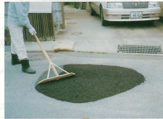
「YKアスコン」は、硬質アスファルトを特殊な方法で、優れた感圧性と粘弾性を持つよう改質したものを結合材としています。そのままではバラバラの状態ですが、外部からの圧力が加えられると、互いに固着して強固な舗装になります。
