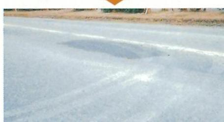
「薄層」は、硬質アスファルトに適度の粘弾性をもたせるように改質したものを結合材として使用していますので、十分な強度と耐久性を持った舗装材です。施工するまではサラサラの粉粒状態ですが、ある程度の圧力を加えて転圧すると、結合材が互いに融着して強固な塊になります。
